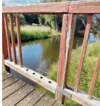
Mittlerweile fehlen einige Holzstreben am Geländer der Tollensebrücke. Einige Schadstellen wurden provisorisch repariert.
